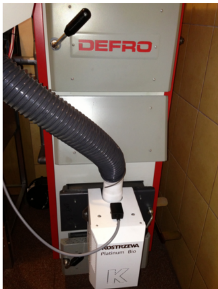
Defro Optima Komfort Plus 15 z zamontowanym palnikiem na pellet firmy KOSTRZEWA Platinum Bio o mocy 16 kW.
